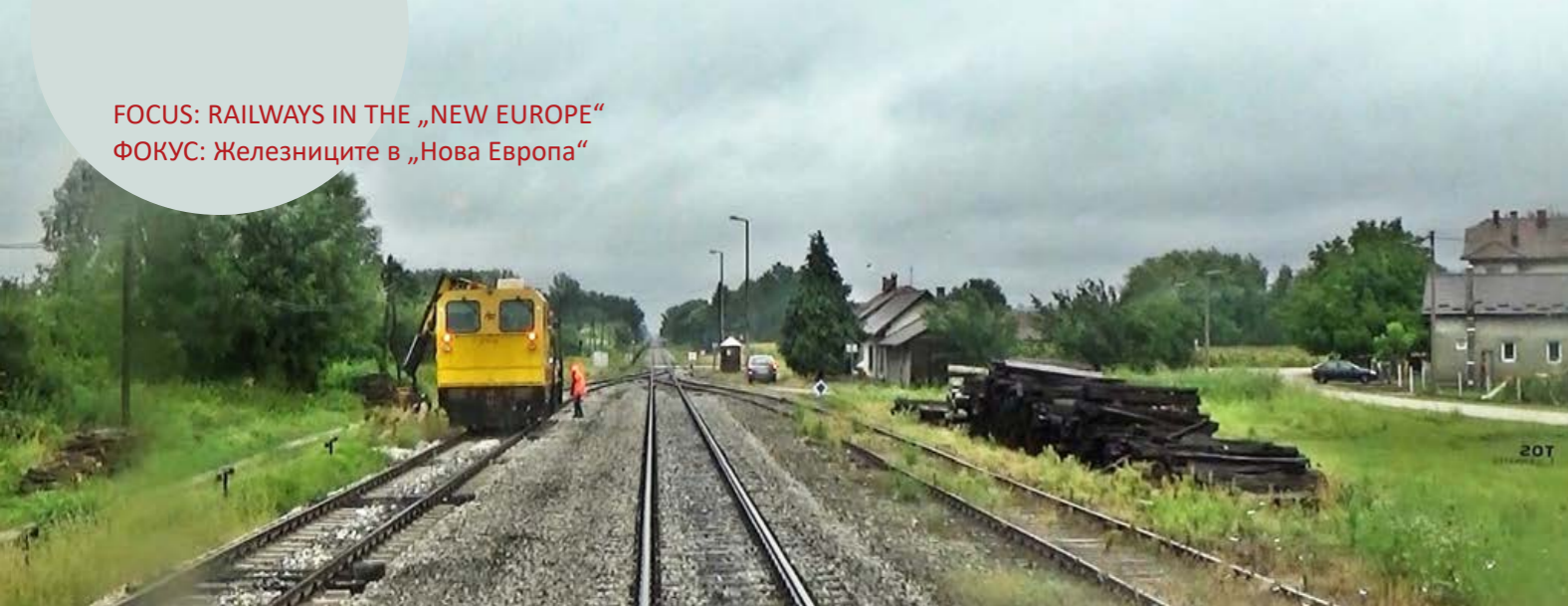
Rasinja railway station: Dilapidated wooden sleepers are being replaced on one of the tracks. ЖП гара Rasinja: Болните дървени траверси се подменят на един коловоз.
